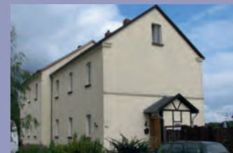
29 | Ehemaliges Pumpengebäude von Rollmanns Brunnen bei Heeren
