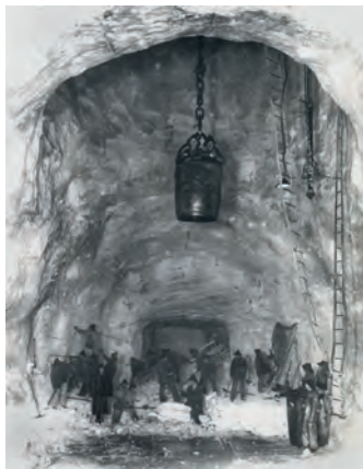
6 | Abteufarbeiten im Bergwerk Borth 1925
