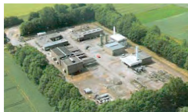
13 | Obertageanlage des Speichers Xanten
