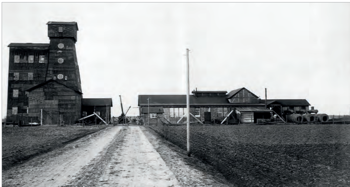
10 | Abteufgerüst des Kalischachtes Friedrichsfeld 1 (1914)
