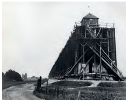
16 | Das 1845 errichtete Gradierwerk „Parallelbau“ nördlich der heutigen Grünanlage am Salinengraben, im Hintergrund die „Feuermaschine“
