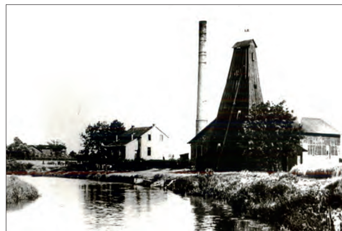
22 | Bohrturm und Pumpenanlage der Bohrung Werries bei Hamm
