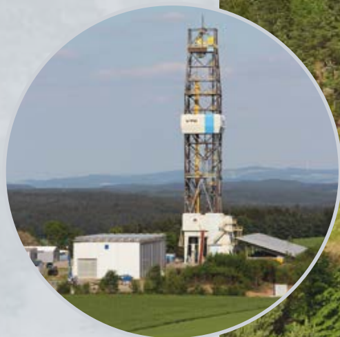
Blick in die Tiefe – Kontinentale Tiefbohrung KTB.
