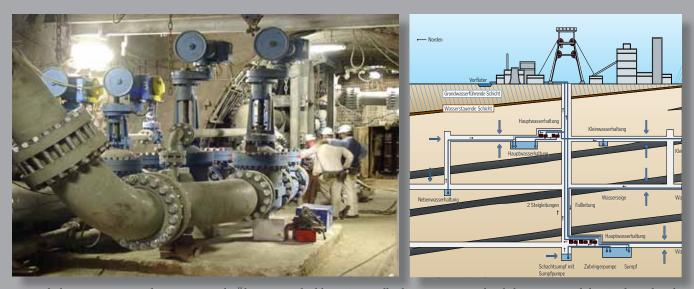
Wasserhaltung in einem modernen Bergwerk: Über eine Vielzahl von Sammelbecken, Pumpen und Rohrleitungen wird das Grubengebäude frei von Wasser gehalten. Erst so ist ein Arbeiten untertage überhaupt erst möglich.
