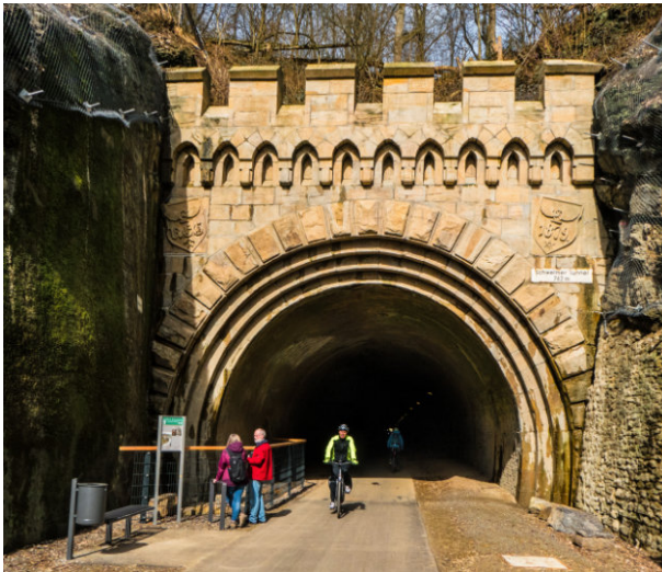
Südportal des Schwelmer Tunnels
