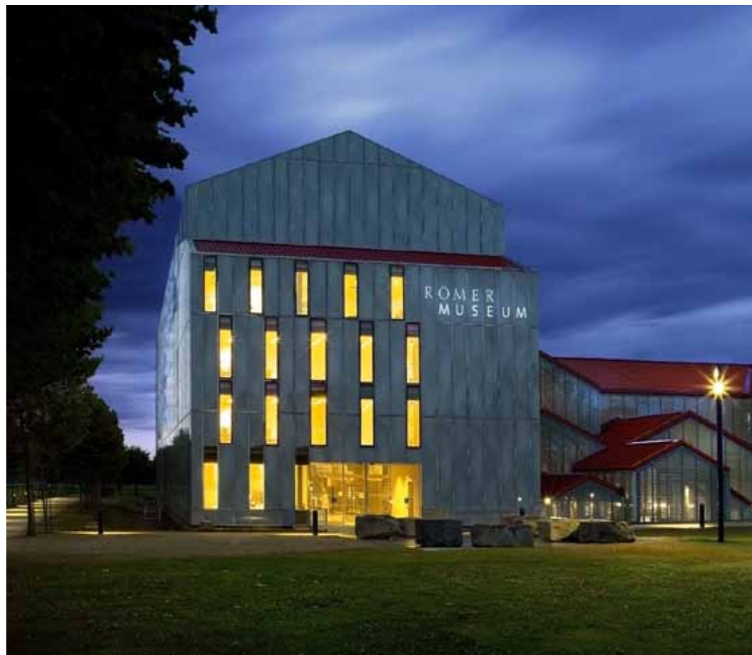
Heizen und Kühlen mit Erdwärme. Das 2008 eröffnete Römermuseum Xanten ist durch die innovative Energieversorgung noch heute am Niederrhein ein Leuchtturmprojekt „Geothermie“.
