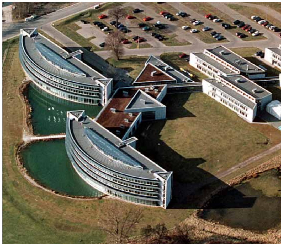
Die idyllischen 2.600 Quadratmeter Ziergewässer vor dem Zentrum sind nicht nur Dekoration, sondern sie dienen auch als Wärmelieferant. 30 Erdsonden und zwei Teichabsorber liefern 260 Kilowatt Heizleistung.
