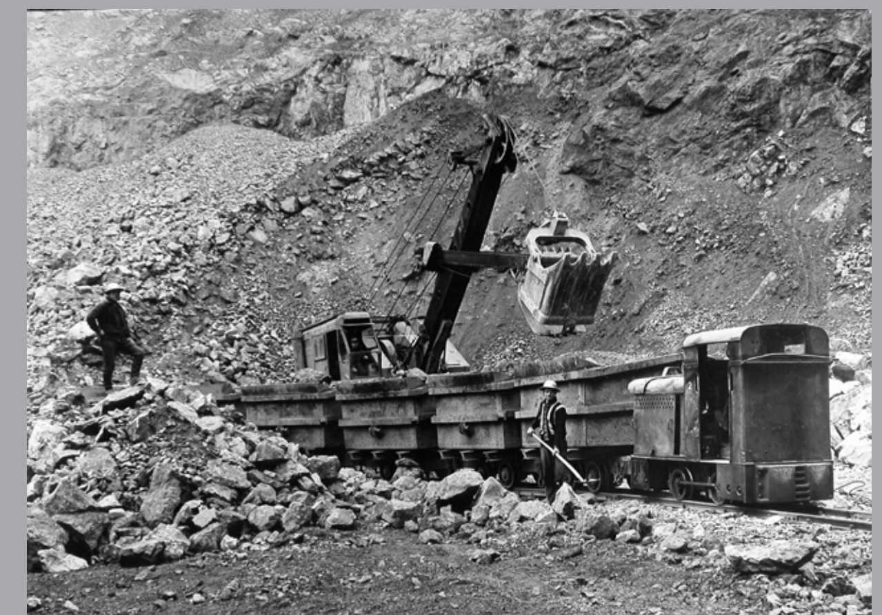
Kalksteingewinnung im Jahr 1956 mit Elektro-seilbagger, Diesellok und 5-Tonnen-Loren. (Foto: HKW)
