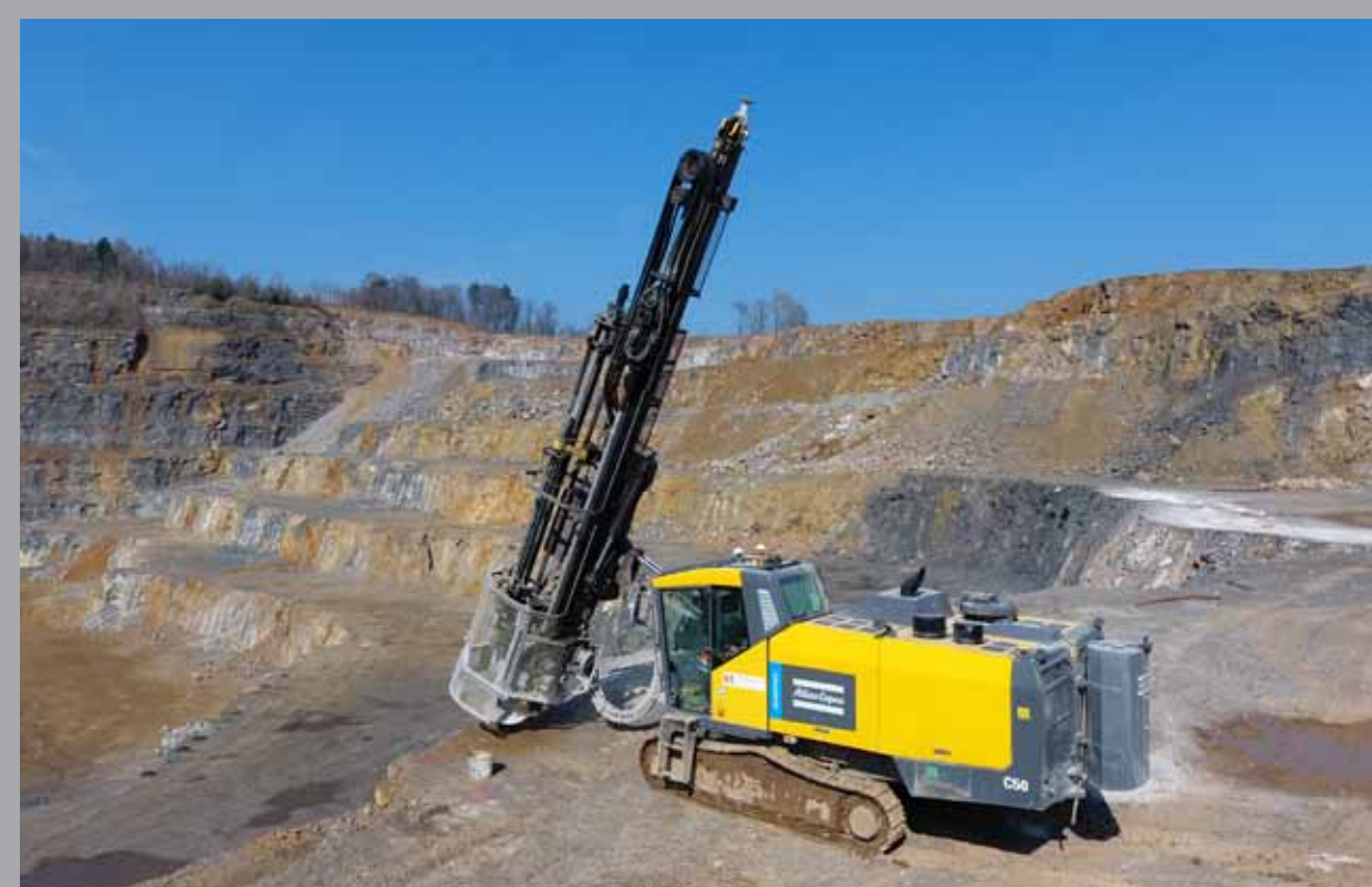
Mit der Gesteinsbohrmaschine werden Löcher in den Felsen getrieben, in die das Sprengpulver eingebracht und gezündet wird.
