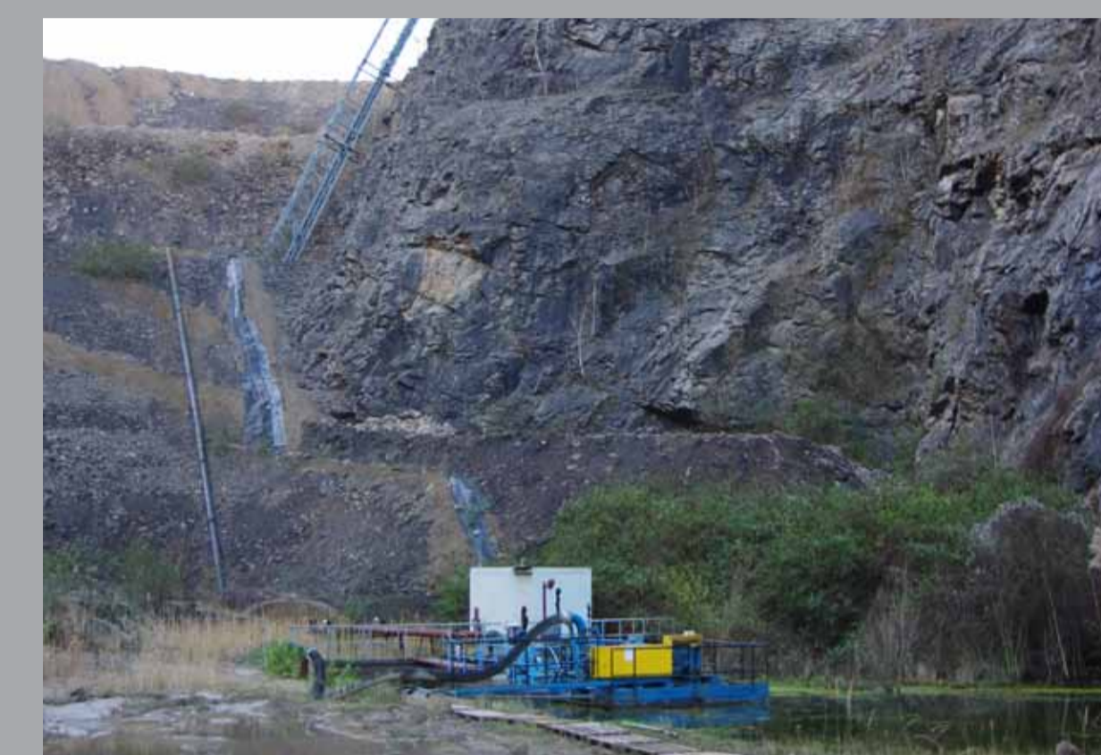
Wasserhaltung im Steinbruch
