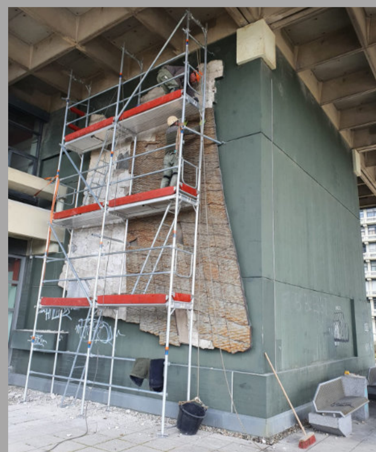
Abbau der Rippelwand am NA-Gebäude der Ruhr-Universität Bochum (Foto: Stefan Voigt)
