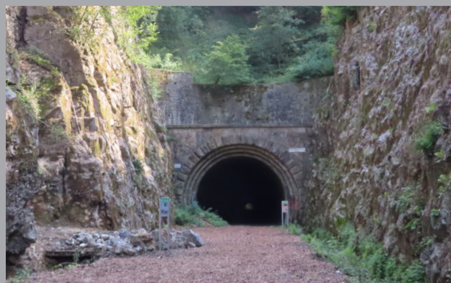
Das Nordportal des Schwelmer Tunnels. Wegen des geraden Verlaufs ist auch der Südausgang zu erkennen.
