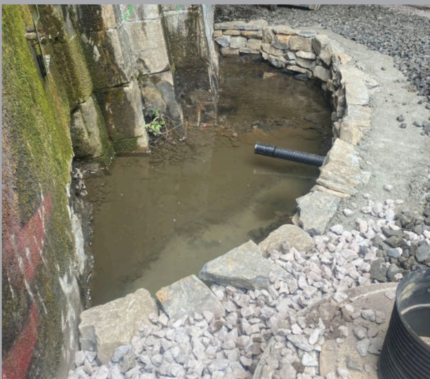
Karstquelle am südlichen Tunneleingang
