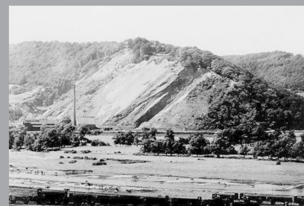
Der Steinbruch und die Ziegelei am Isenberg im Jahr 1910
