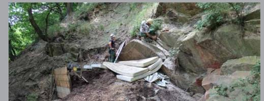
Die Platte wird durch Keile gelöst,
