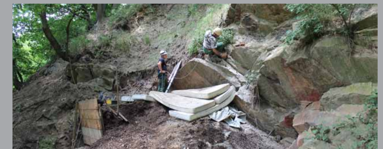
Die Platte wird durch Keile gelöst.
