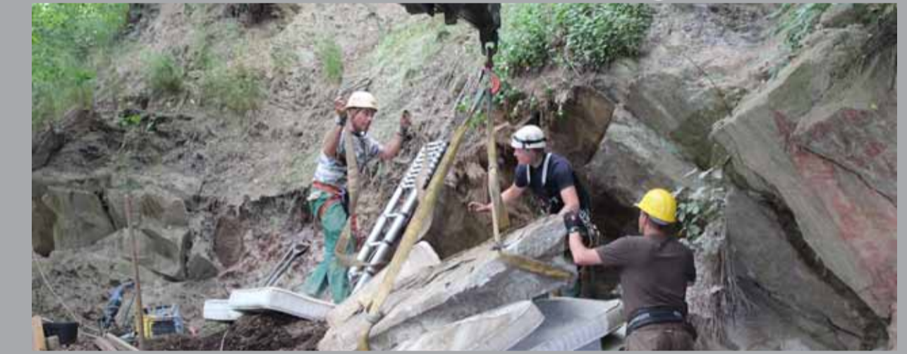
... und mit einem Kran gehoben.
